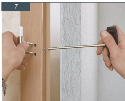
Sada uspravite dovratnik i utaknite šarnire u provre gore i dolje. Učvrstiti ih možete s unutarnje strane.
