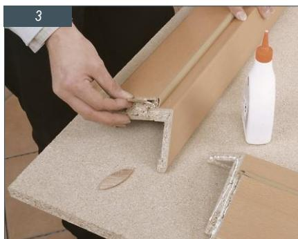
Utaknite plosnati tipu u predviđeni prorez elementa dovratnika. Sada nanesite ljepilo i spojite elemente.
