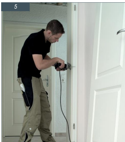
Unutarnji okvir starog dovratnika se u donjoj trećini prepili čistim rezom.
